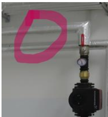
Wskazane miejsce montażu zaworów
